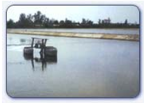
รูปที่ 8 ระบบเติมอากาศแบบเวนจูรีชนิดติดตั้งบนทุ่นลอย
